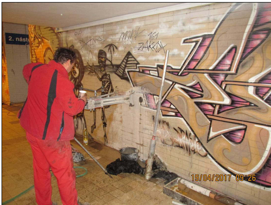
Obr. č. 11 - provádění diagnostického vrtu V1 - opěra Maloměřice
